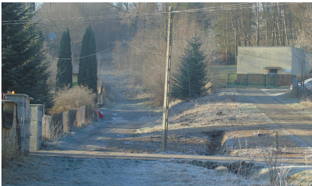
Odtworzenie rowu przy drodze do zbiornika wodnego w msc Tumlin - Dąbrówka
