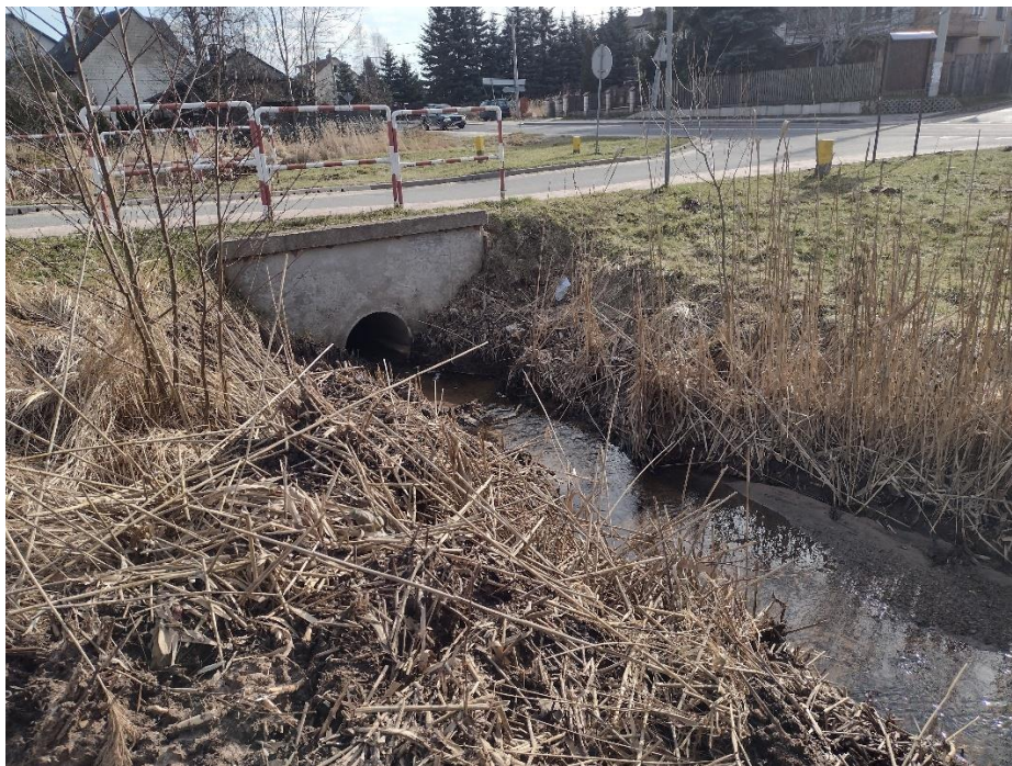
Udrożnienie przepustu pod ul. Jana Pawła II w Zagnańsku
