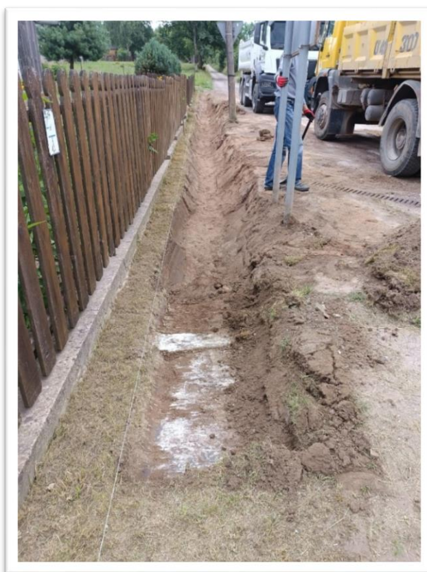
Wykonanie rowu odwadniającego – ul. Akacyjowa
