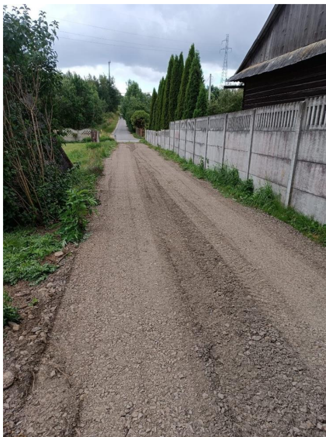
Wykonanie drogi dojazdowej do drugiej linii zabudowy w msc. Zabłocie
