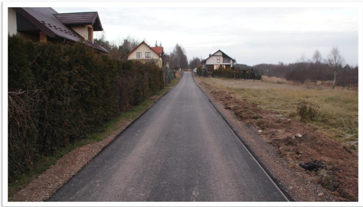
❖ Gruszka, ul. Uroczą – wykonanie nakładki asfaltowej wraz z utwardzeniem pobocza na długości 186 m. Wartość zadania wyniosła 52 457,73 zł
