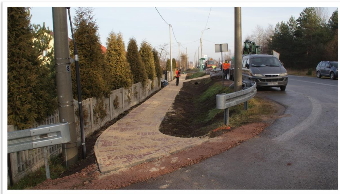
❖ Wykonanie chodnika długości 50 m przy starodrożu dróg krajowych nr 7 i 73
