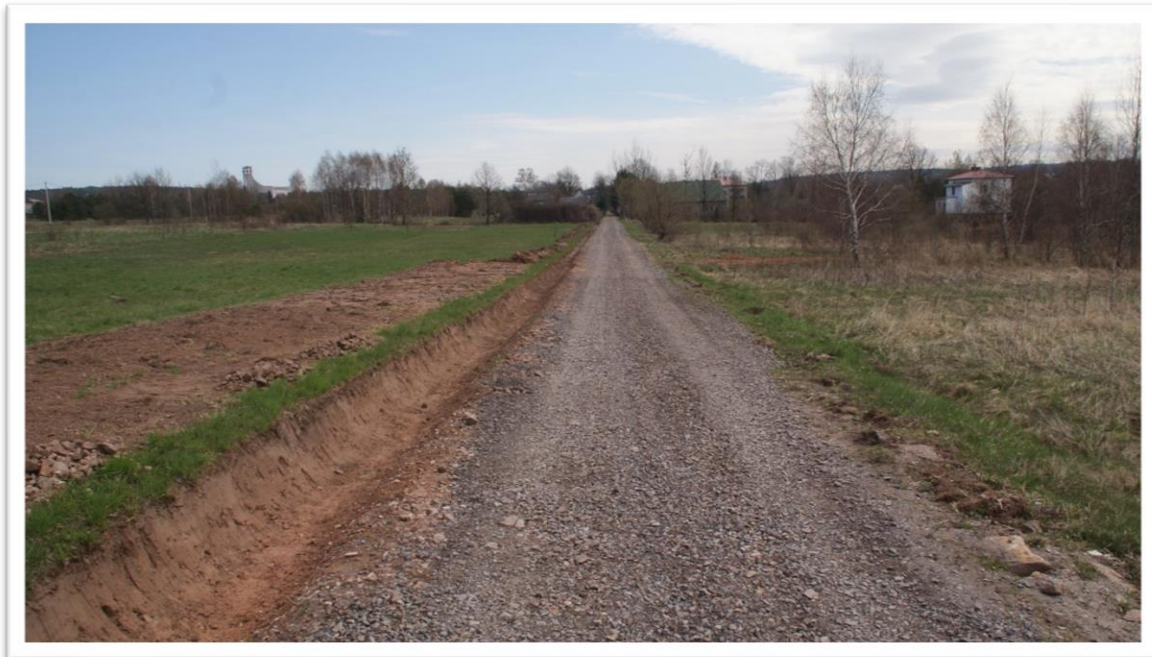
❖ Remont drogi w msc Samsonów – Piechotne „Kępa”, udrożnienie rowów i wykonanie nakładki z kruszywa
