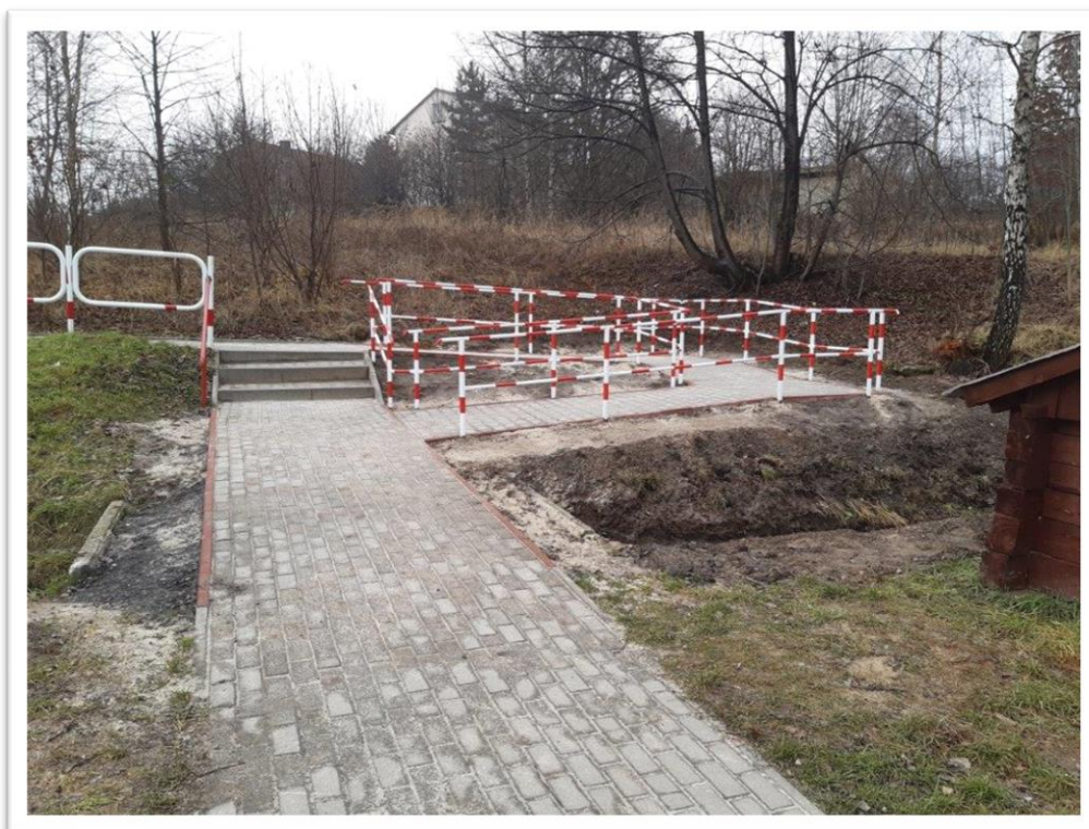
❖ Kajetanów wykonanie rampy dla wózków inwalidzkich
